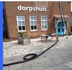
De spouwmuren zijn al op 19 juli geïsoleerd
